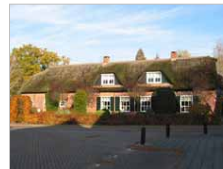
langgevelboerderij, Den Dries
