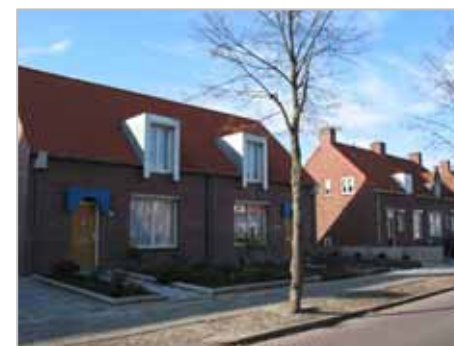
modernisering woningen, Diepstraat
