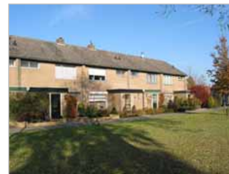
plasticiteit gevels gevarieerd, Berkenring
