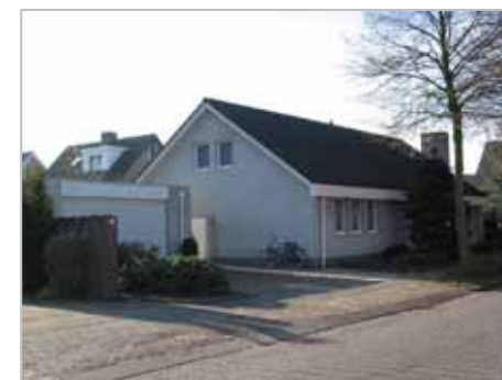
niet passend; afwijkende bouwmassa, materiaal en kleurgebruik, Achtmaalseweg
