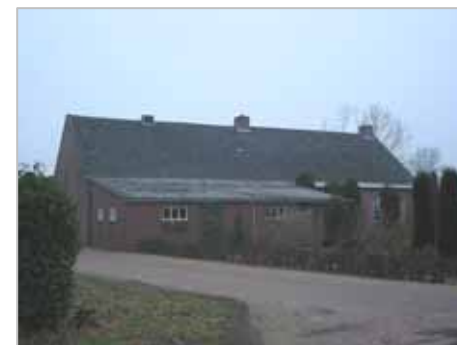
niet passende uitbouw aan de voorzijde, Grote Heistraat
