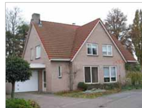
nieuwbouw 2/1-kap, Hofdreven
