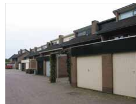
garages aan voorzijde woning, Wolfsheining
