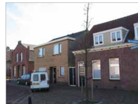
lintbebouwing, Past. de Bakkerstraat
