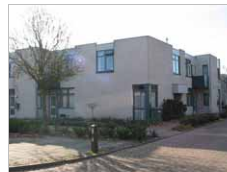
niet passend; plat dak, A. Juriënplein
