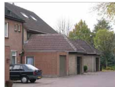
kap op uitbouw; niet passend, Het Steke
