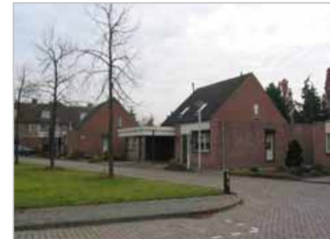
uniform kleur- en materiaalgebruik, Lindenlaan
