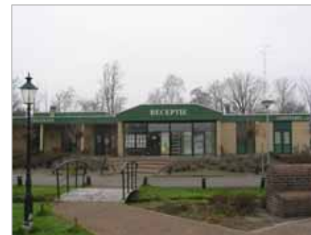
voorzieningsgebouw recreatiepark 'Patersven', Kleine Heistraat
