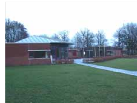
verzamelgebouw, sportterrein Wildertsedijk
