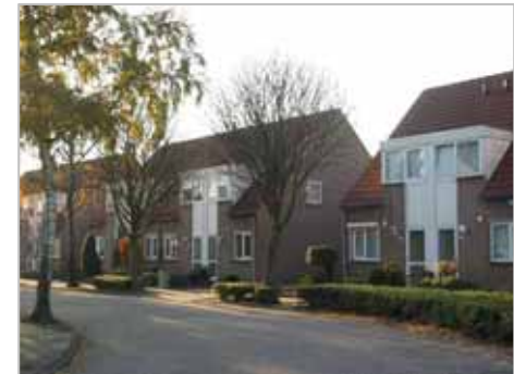
2/1-kap woningen, Nachtegaalstraat
