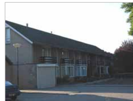
herhaling binnen bouwblok, Nassaustraat
