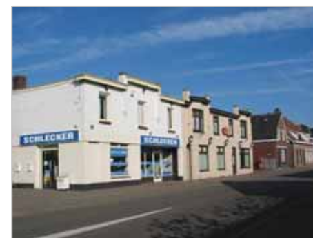
historische lintbebouwing, Wernhoutseweg
