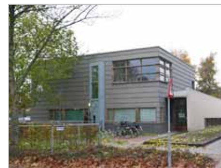
kinderdagverblijf, Burg. Gommersstraat
