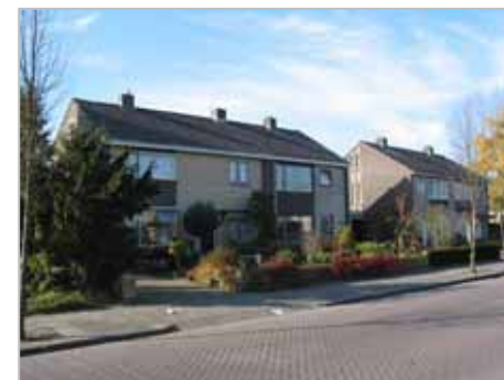
2/1-kap woningen, Diepstraat
