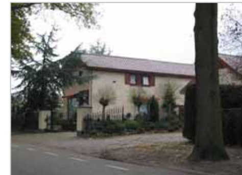
afwijkende bouw-massa, Nieuwmoerseweg
