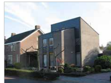
afwijkende massa en kapvorm, Past. Bielarstraat
