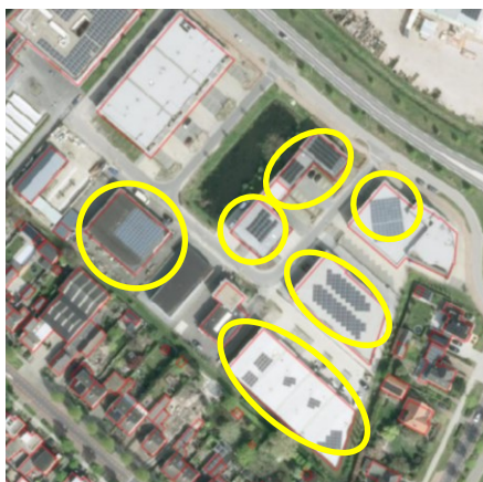
Figuur 5: Geplaatste zonnepanelen peilmaand september 2024
